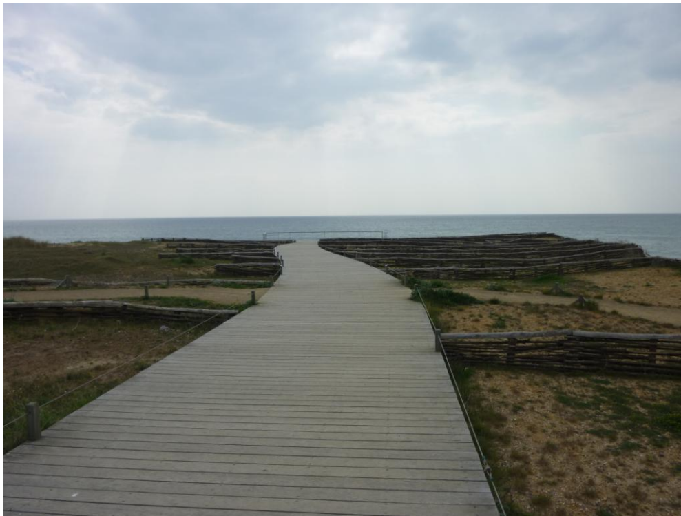
Photographie 26. Platelage pour accéder au site de la Corniche situé sur les communes de Saint-Gilles-Croix-de-Vie et Saint-Hilaires-de-Riez
