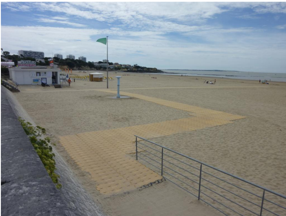
Photographie 27. Chemin de plage en dalles à Saint-Georges-de-Didonne
