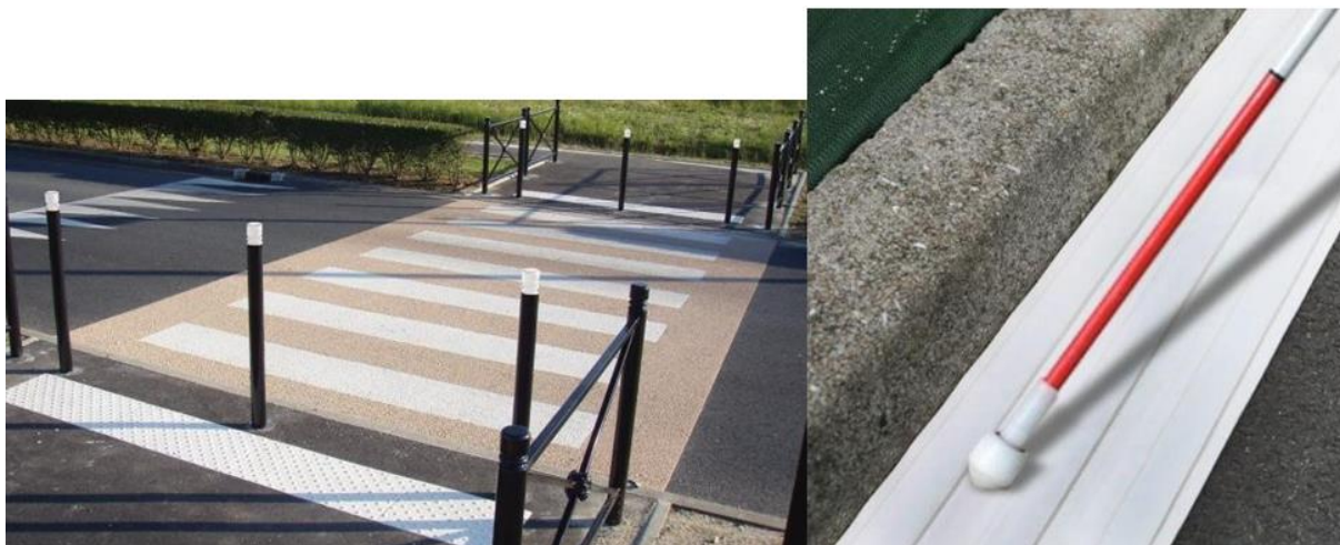
Figure 28. Marquage au sol : lignes pour le guidage et bandes podotactiles pour indiquer un passage piéton
