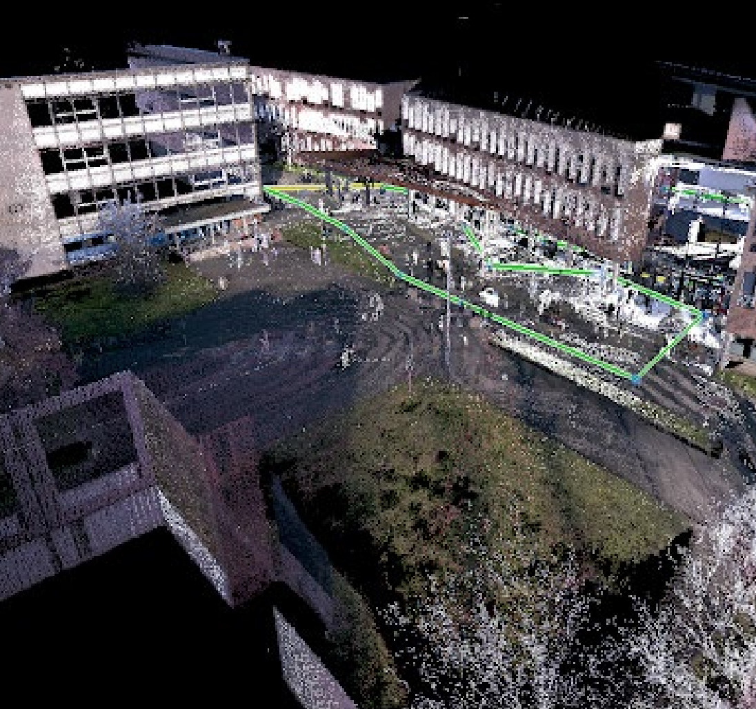
Figure 21: Vue 3D depuis le logiciel Register 360 suite au scan d'une partie du SH3 (Université de Lille) pour le cheminement depuis l'extérieur du bâtiment jusqu'à une salle de cours au second étage. Source: Equipe UP, Laboratoire TVES, 2022
