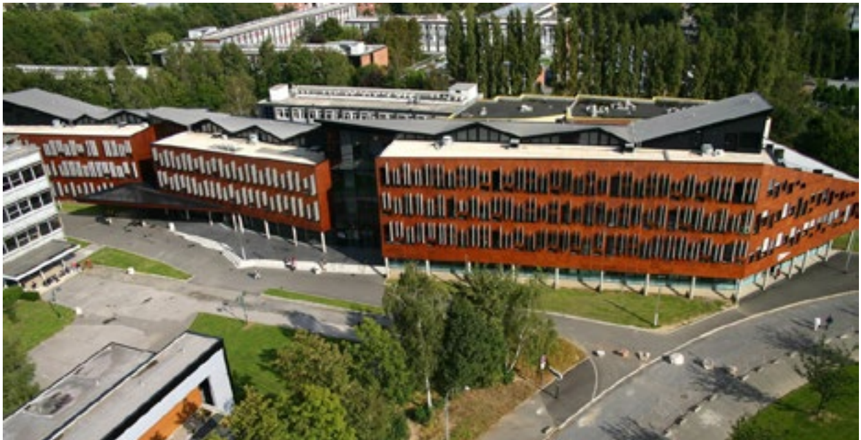
Figure 54: Photographie aérienne du bâtiment SH3. Source: Blaq Architecture
